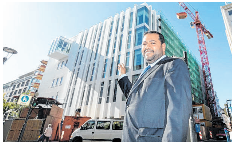
Projektleiter Awes Khan freut sich über die neue Fassade nach dem Umbau. Als Blickfang dient der Erker im vierten Obergeschoss. BILD: BLÜTHNER
